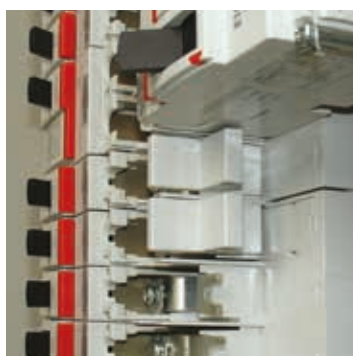
POLOS AISLADORES • Sirven para aislar los polos no utilizados cuando se dejan espacios futuros en el tablero o cuando algún interruptor ha sido removido.
